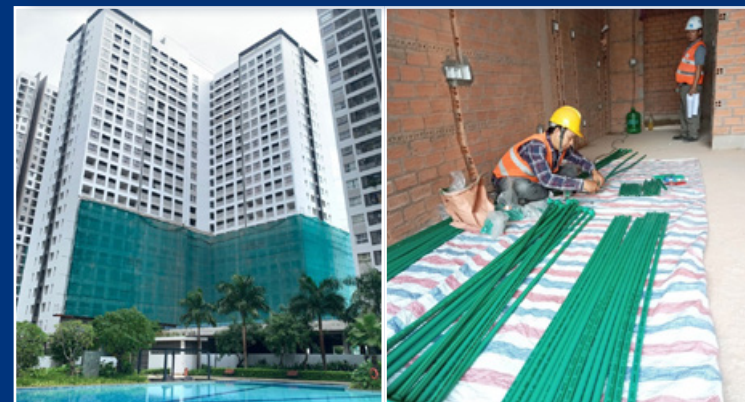
Hình ảnh thi công tại công trường tháng 7/2023
